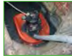
Extracción de agua desde pozos.
