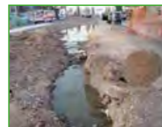
Tareas en el alcantarillado público.
