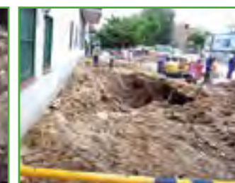
Trabajos de perforación y obra pública.
